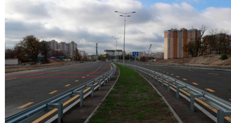
БУДІВНИЦТВО ВЕЛИКОЇ ОКРУЖНОЇ ДОРОГИ
