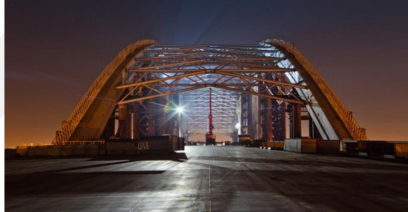
БУДІВНИЦТВО ПОДІЛЬСЬКОГО МОСТОВОГО ПЕРЕХОДУ ЧЕРЕЗ Р. ДНІПРО
