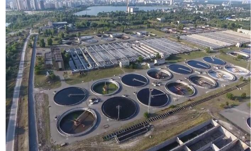
РЕКОНСТРУКЦІЯ БОРТНИЦЬКОЇ СТАНЦІЇ АЕРАЦІЇ
