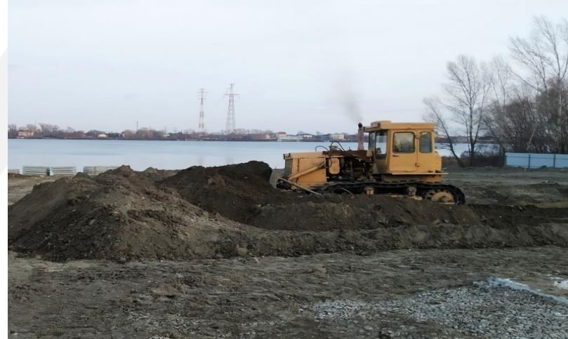
РЕКОНСТРУКЦІЯ ДЮКЕРНИХ ПЕРЕХОДІВ ЧЕРЕЗ Р.ДНІПРО
